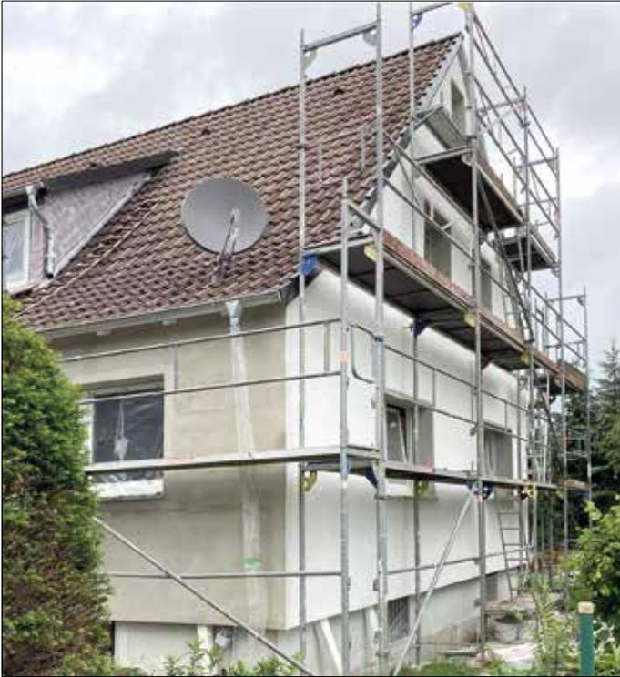
Ein entscheidender Faktor war die Fassadendämmung. Zum Einsatz kam ein mineralisches Steinwolle-WDVS, das auch im Brandfall höchstmöglichen Schutz bietet. (Bild: Heck Wall Systems)
