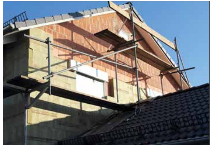
Auf Steinwolle-WDVS lassen sich nahezu alle Oberflächen gestalten. Das verleiht jedem Haus eine persönliche Note. Hier gefalzter Oberputz mit Klinkerriemchen. Bildquelle: „Deutsche Rockwool / Heck“
