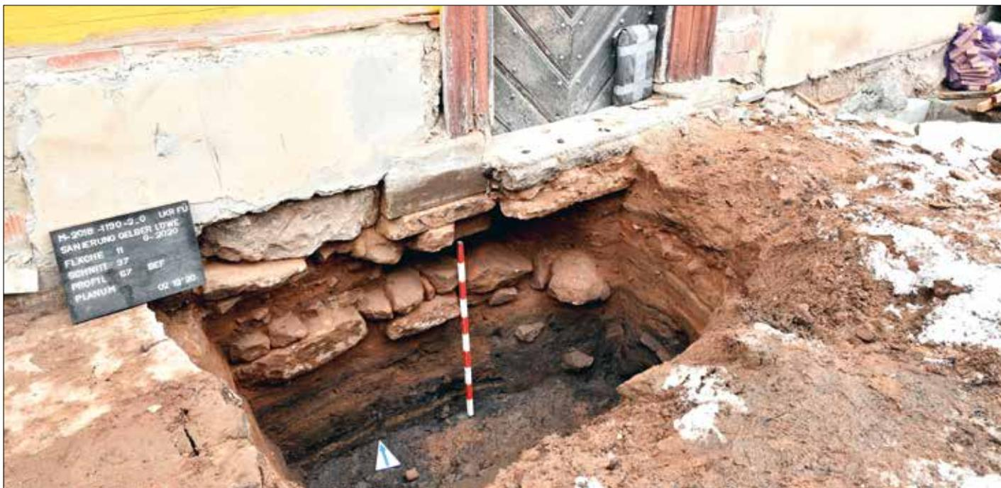
Eingang auf der Südseite mit alter Türschwelle und schwachem Fundament
